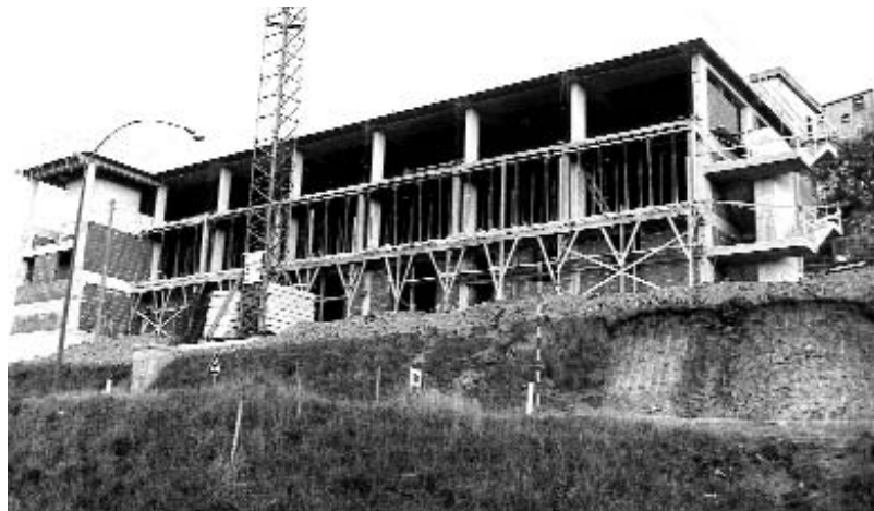
Il centro diurno in costruzione a S. Mauro (foto Giuseppe Cavoli)
